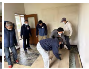
(本館2階床はがし作業)
